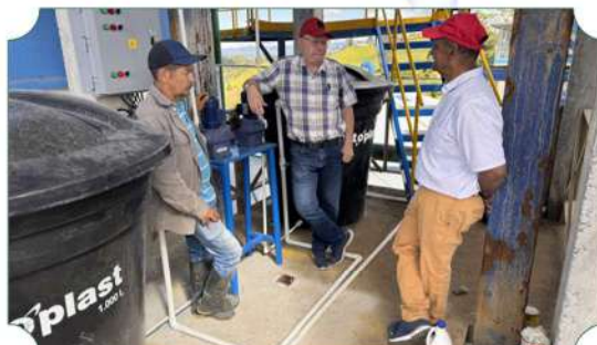
Montaje Tanques, Tablero Electrónico Y Bombas Dosificadoras De Químicos Para Mejorar Tratamiento Del Agua Con Mayor Capacidad
