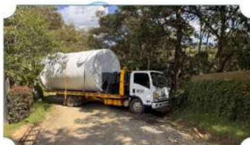
Transporte E Ingreso Clarificador Nueva PTAP Automatizada Para Instalar En Sector Patio Bonito Vereda San Ignacio
