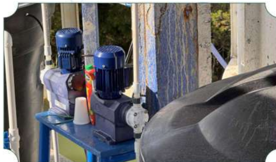
Montaje Bombas Dosificadoras De Químicos Para Tratamiento Del Agua Con Mayor Capacidad
