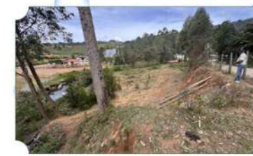
Predio Propiedad Asacuhan Para Construcción Y Montaje PTAP Y Sistema De Bombeo Vereda Yolombal Tanque De Almacenamiento Vereda La Clara
