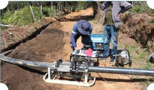
Brechado, termofusión E instalación tubería Pead 110 Mm, Sector Patio Bonito, Vereda San Ignacio
