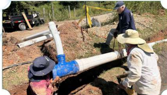
Brechado Y Empalme tubería Pvc 8 Pulgadas A Red Pvc De 4 Pulgadas, Sector Ratón Pelao, Vereda Canoas
