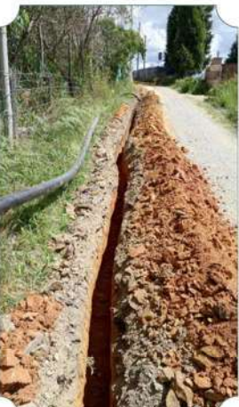
Brechado, termofusión E instalación tubería Pead 110 Mm, Tramo Alto Gilberto Llano A Sector Ratón Pelao, Vereda Canoas
