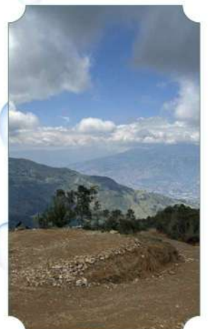
Alto Del Morron, Donde Instalaremos Tanque De Almacenamiento De 500 M3 A Llenar Por Bombeo
