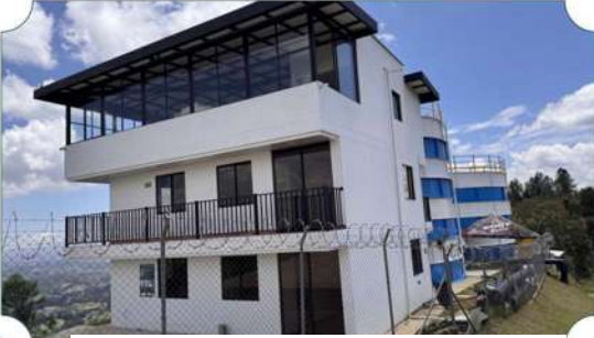
Sede De Operación, Convenio De Interconexión Acueductos La Chorrera, El Colorado, Juan XXIII Y Asacuhan
