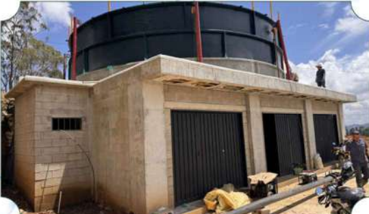
Avance Construcción Tanque De Almacenamiento Fvpr 570 M3 Y Bodega, Ubicado Sector San Miguel Parte Alta, Vereda La Honda
