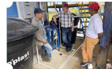
Montaje Tanques Tablero Electrónico Y Bombas Dosificadoras De Químicos Para Mejorar Tratamiento Del Agua Con Mayor Capacidad
