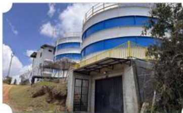
Construcción bodega y tanque de almacenamiento 500 m3, parte alta de la vereda La Mosquita
