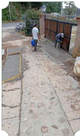
Reparación Rieles En Concreto, Donde Se Hizo Empalme Tubería Pead 315 M3, Iglesia Del Camino, Vereda La Mosquita,
