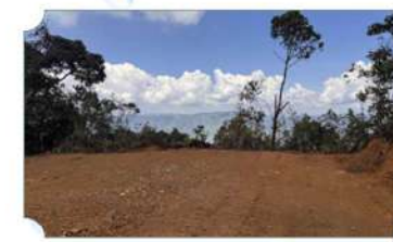
Predio De Asacuhan Para Construcción Losa Soporte En Concreto E Instalar Tanque De Almacenamiento 570 M3 Alto De La Virgen Municipio De Copacabana
