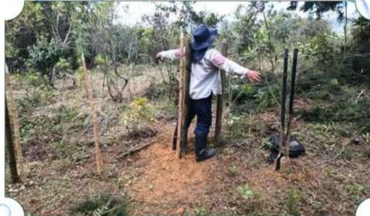
Mantenimiento Cerramiento Predios De Protección Hídrica
