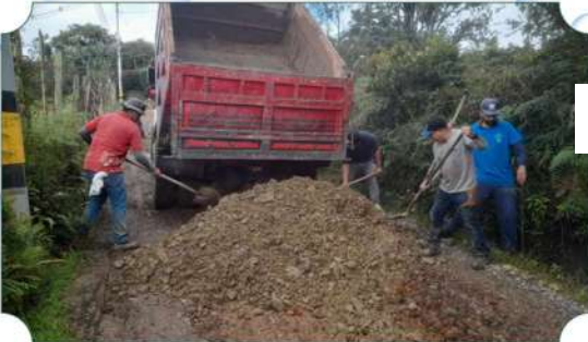
Cribado Para Arreglar Vías Por Donde Instalamos Tubería Pead 315, Vereda La Mosquita
