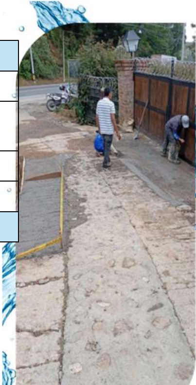
Reparación rieles en concreto, donde se hizo empalme tubería ped 315 m3, iglesia del camino, vereda la mosquita, esta pendiente concreto PARA REPARAR RIELES
