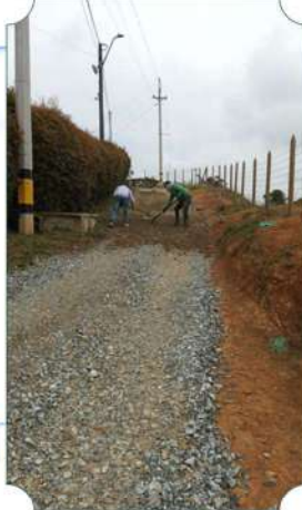
Cribado Para Arreglar Vías Por Donde Instalamos Tubería Pead 315, Vereda La Mosquita
