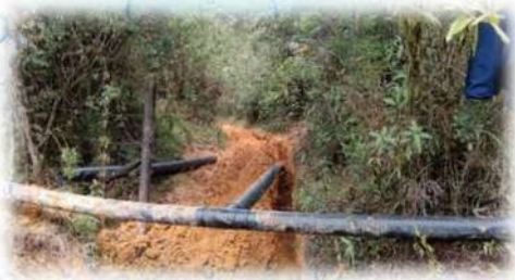
Brechado, termofusión e instalación tubería 160 mm parte alta, vereda alto de la virgen
