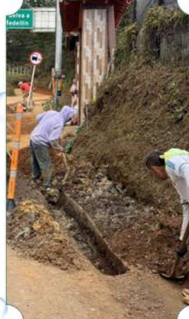
Brechado, termofusión E Instalación tubería Pead 160 Mm, Vereda Barroblanco
