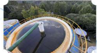
Instalación Paneles Para Mejorar sedimentación Agua En Ptap La Hondita
