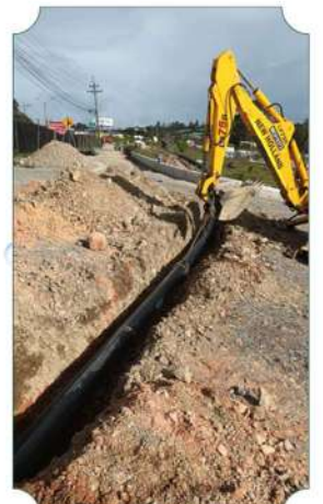
Brechado, Termo fusionado E instalación tubería Pead 200 Mm, Sector PepsiCo A Entrada Vereda Toldas
