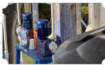
Montaje Bombas Dosificadoras De Químicos Para Tratamiento Del Agua Con Mayor Capacidad
