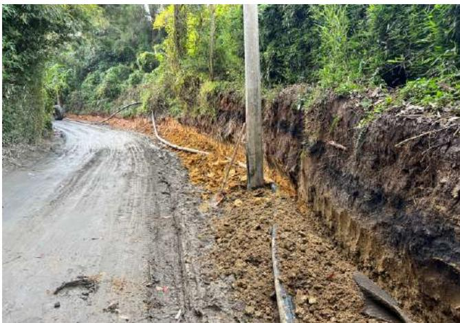
*Instalación tubería Pe Ad 4 vía La Clarita, Vereda Bellavista (2)*
