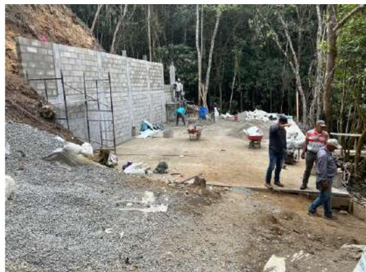
*Losas de soporte para instalación de planta de tratamiento y tanque almacenamiento de 300 m3, proyecto nuevo sistema de acueducto por gravedad san isidro y por bombeo a alto del morrón (2)*
