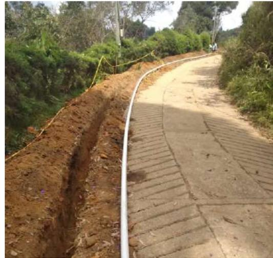
*Instalación Tubería PVC RDE 21 um de 2 pulgadas, vereda La Honda*
